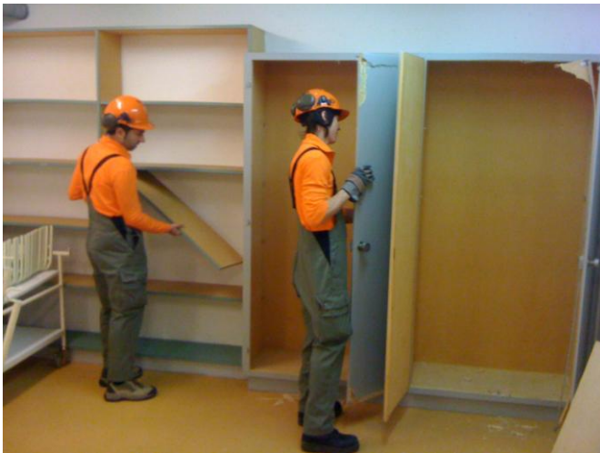
Rückbau der Infrastruktur
