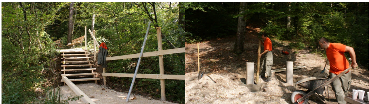
Die Treppe, Brücke und das Geländer so wie die Fundamente wurden komplett erneuert.
