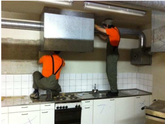
Pioniere beim Ausbau der Küche und der Abluftanlage wurden entfernt
